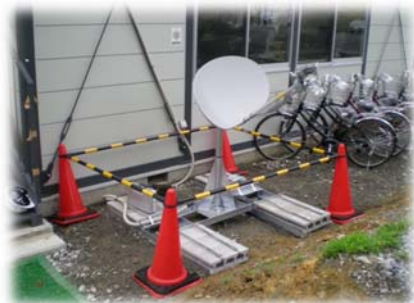
【VSAT設置状況】
