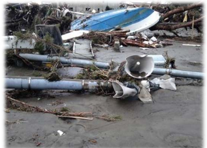
【宮城県東松島市：防災行政無線の子局被害状況】
