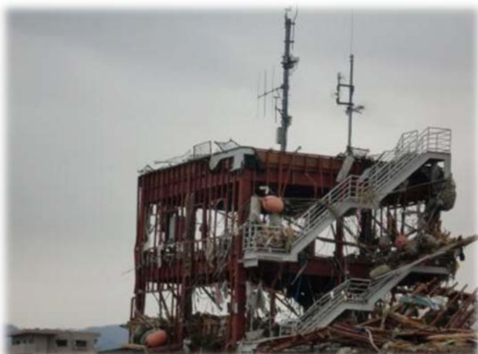
【宮城県南三陸町：防災行政無線の親局があった防災庁舎（全壊）】
