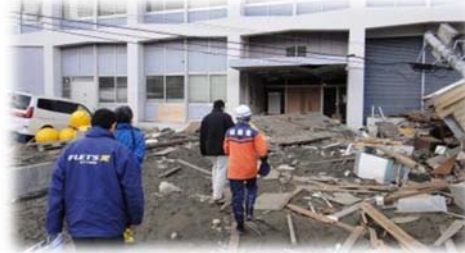
【石巻市：NTT局舎被害状況調査】
